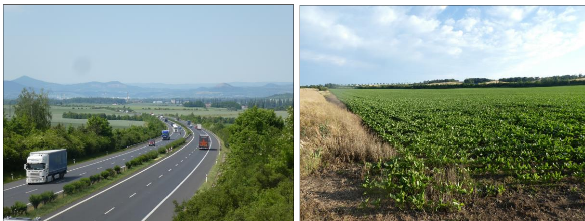
Obr.č.25 Dálniční těleso při pohledu z mostu II/246, v pozadí panorama Českého středohoří (vlevo), pohled směrem k dálnici a navržené odpočívce Dušníky P od východu (vpravo)
