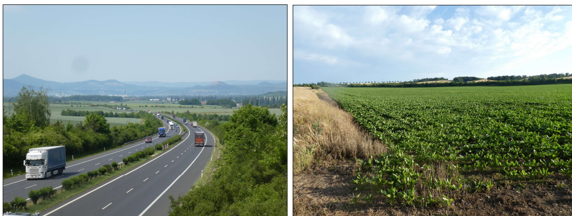
Obr. 7: Dálniční těleso při pohledu z mostu II/246, v pozadí panorama Českého středohoří (vlevo), pohled směrem k dálnici a navržené odpočívce Dušníky P od východu (vpravo)
